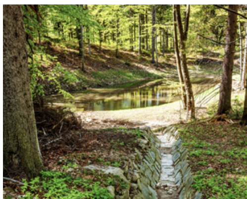
Fot. 14. Zbiornik zasilany spływami powierzchniowymi, w tym korytem kierującym wodę z wyso- czyny lub drogi w Nadleśnictwie Piwniczna, 2015 (archiwum CKPŚ)
