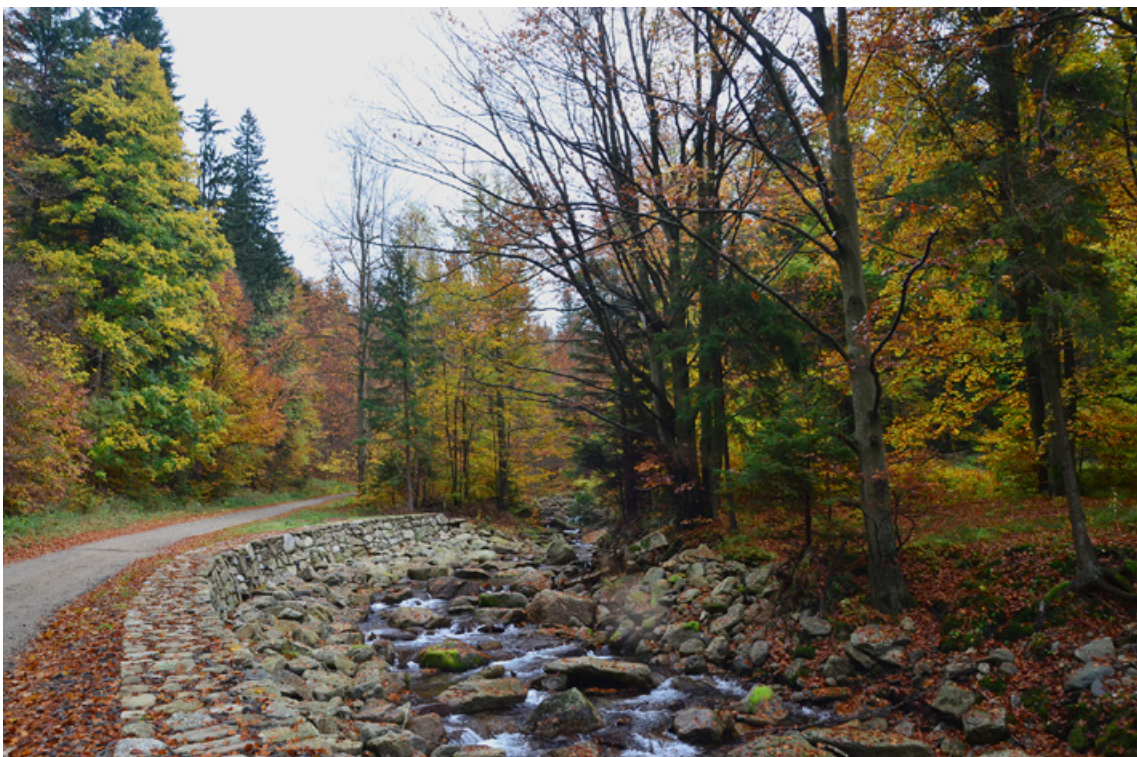
Fot. 3. Zabezpieczenie brzegu niewielkim murem oporowym w celu ochrony infrastruktury drogowej, Nadleśnictwo Międzyzlesie (archiwum CKPŚ)
